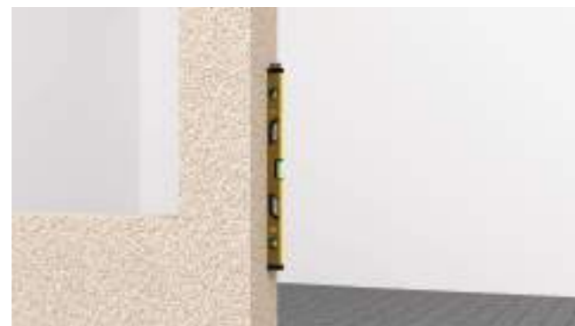
2 Contrôler les niveaux des 2 piliers; Control the levels of the 2 pillars;
